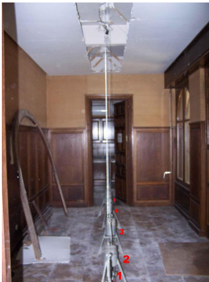
Foto nº 6: Vista General del paño 2 ensayado.
